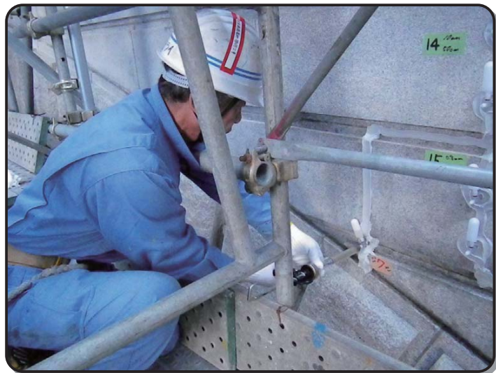
▲樹脂注入状況
