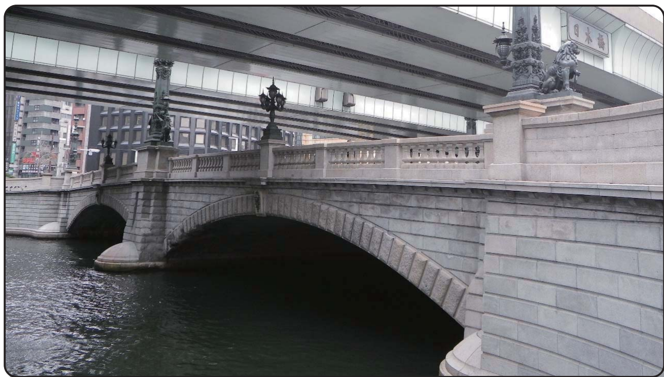
▲補修工事後の日本橋
