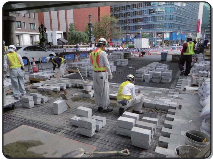
▲網鉄筋の設置状況
