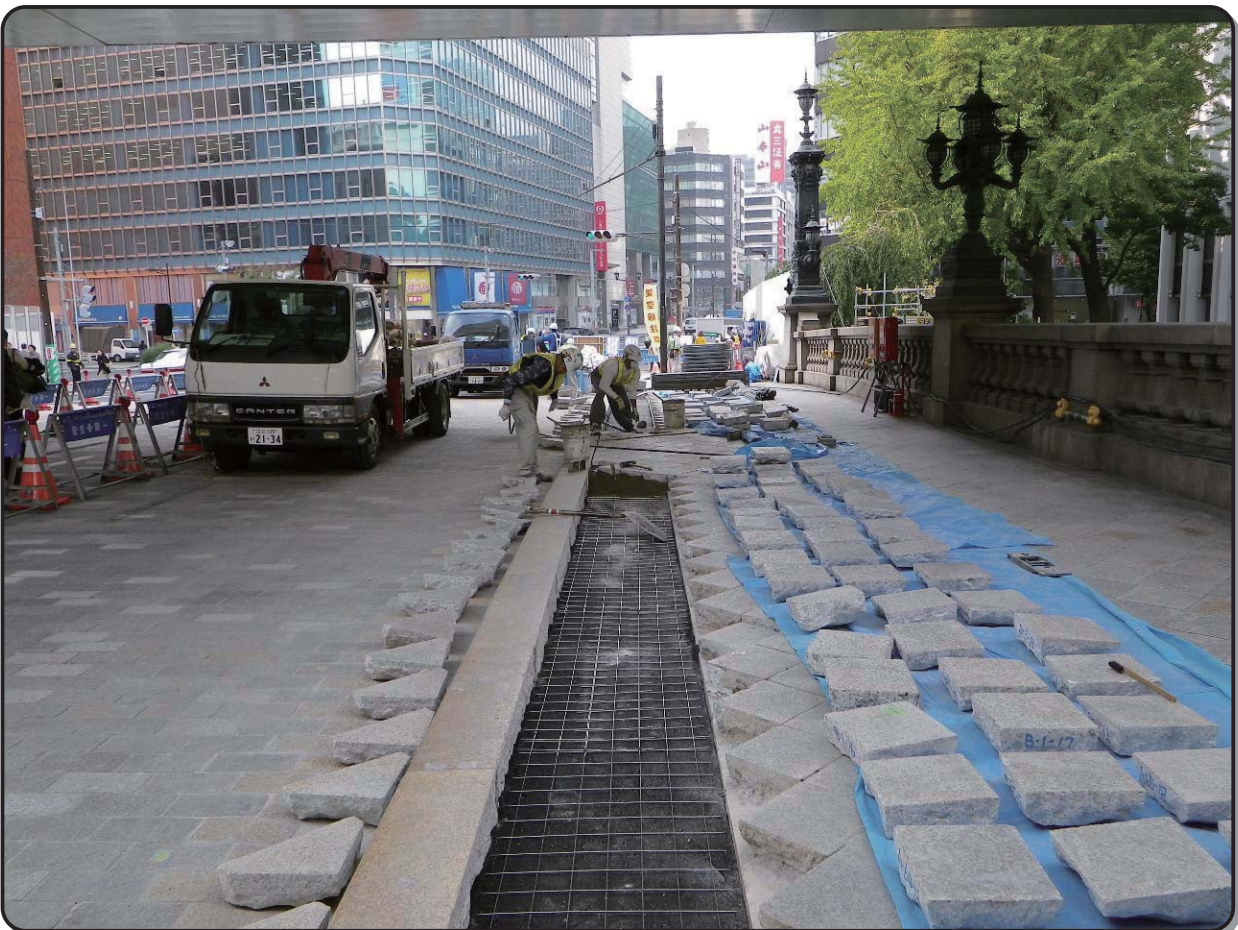
▲歩道部分の石の復旧状況
