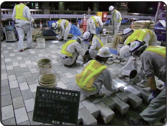
▲セメントペースト作業状況
