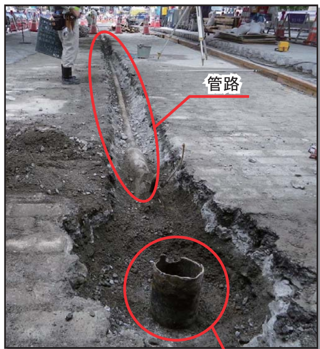
▲東京市道路元標の基礎と管路
