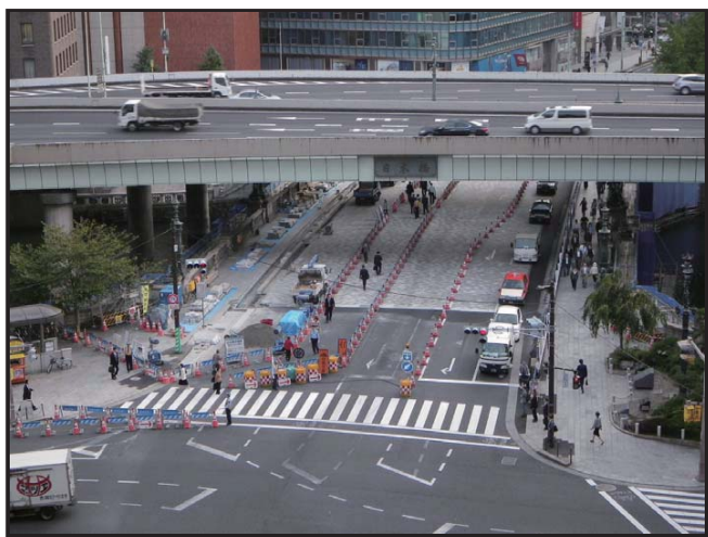
▲工事中も車の通行を確保しました
