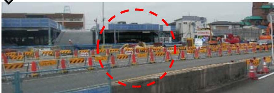
写真 1-12 仮設の中央分離帯のバリケードを改善した状況
