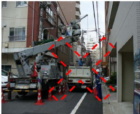
写真 2-11 作業帯外で作業しており、危険な状況
