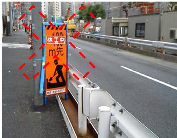
写真 1-13 工事エリアに、隣接する工事の予告看板があり、ドライバーを混乱させている状況
