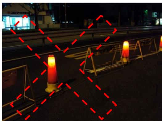
写真 2-3 歩行者通路の車道側に大きな隙間がある状況
