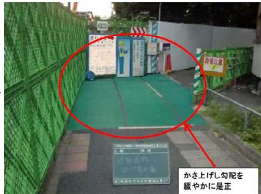
写真 2-10 直線部分に段差擦り付けをした
