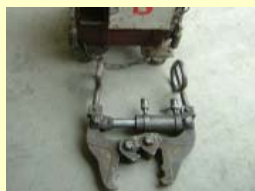
ハンドクラッシャによる施工
