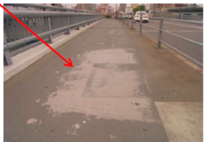
※写真3は、四ツ木小橋 (綾瀬川上)
