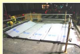
防音シートの設置
