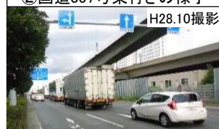
②国道357号東行きの様子
