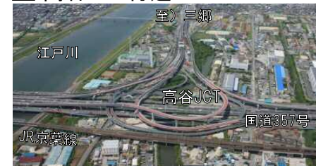
③ 高谷JCT付近
