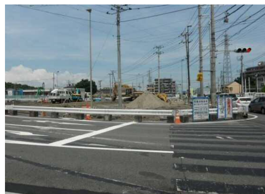
・武蔵野橋北交差点付近の施工状況 【平成30年6月 撮影】
