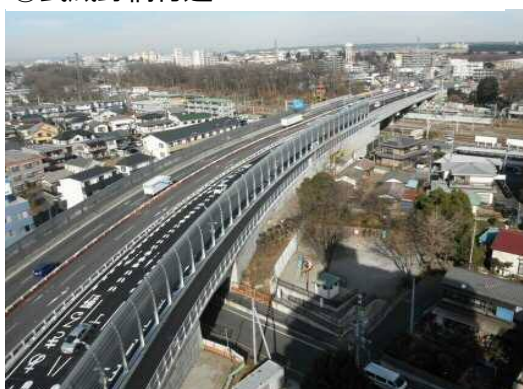
・武蔵野橋完成 【平成30年1月 撮影】
