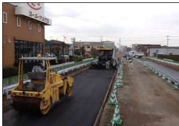
・豊田南地区 歩道工事施工状況 【平成30年11月 撮影】
