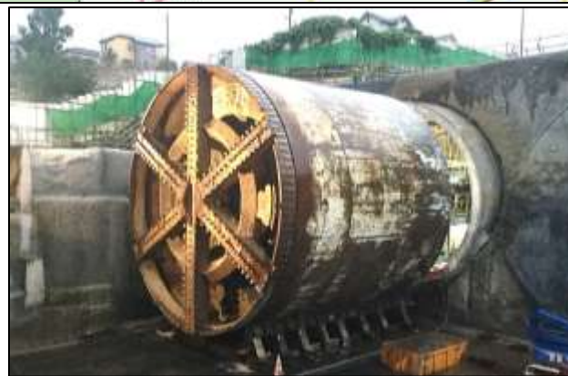
・館第一トンネル(シールド機 下り線貫通状況) 【平成30年9月 撮影】
