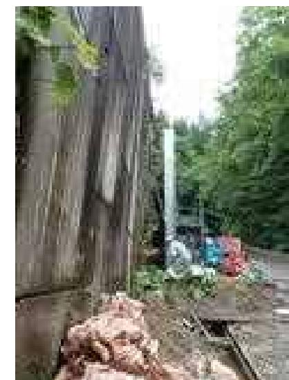
写真 壁面の傾斜の例
