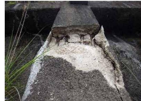
法枠工の老朽化損傷
