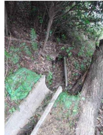
写真 排水溝の破損の例
