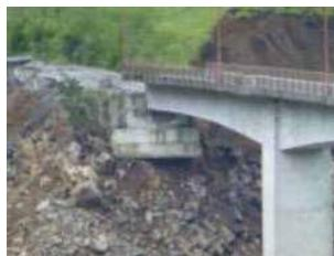
斜面変状による橋台の沈下
