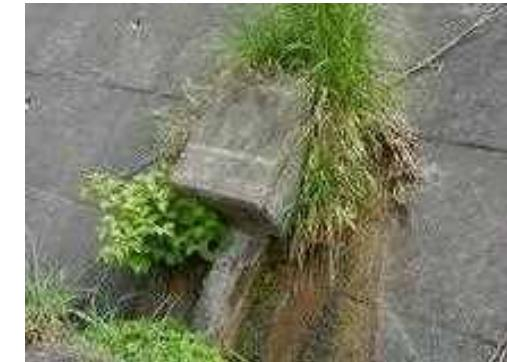
写真 アンカーの頭部からの湧水・雑草の繁茂の例
