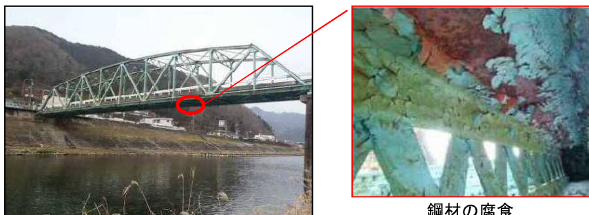
鋼材の腐食
