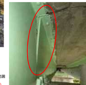
主桁の変形
