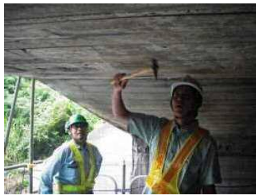
目視及びハンマーによる打音検査
