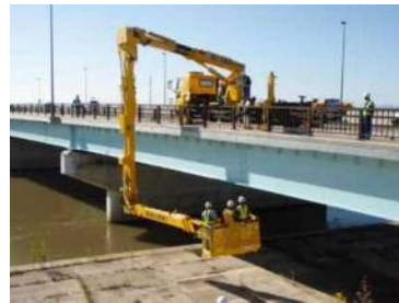
橋梁点検車による点検
