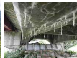
主桁のひびわれ
