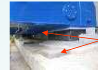
支那交換が容易な構造の例
