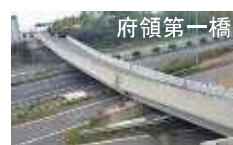
ロッキング橋脚を有する橋の落橋
