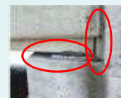
支那交換や桁端点検の空間なし
