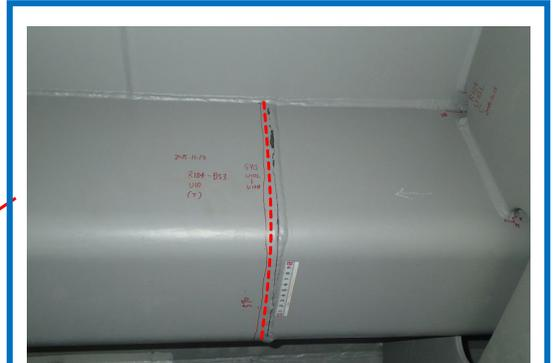
⑤縦リブ突合せ溶接部のき裂 (TypeB)
