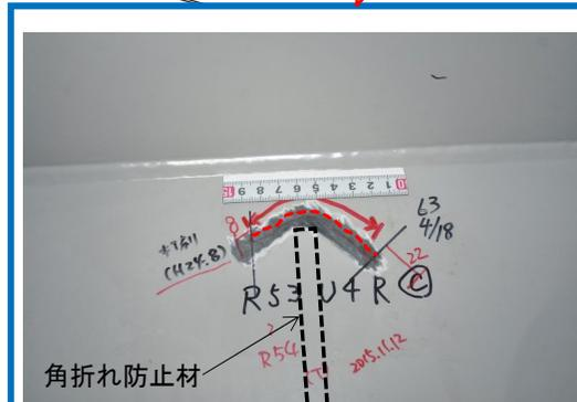
③角折れ防止材による縦リブのき裂 (TypeG)
