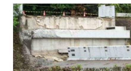
写真-2 横変位拘束構造の破壊、落橋
