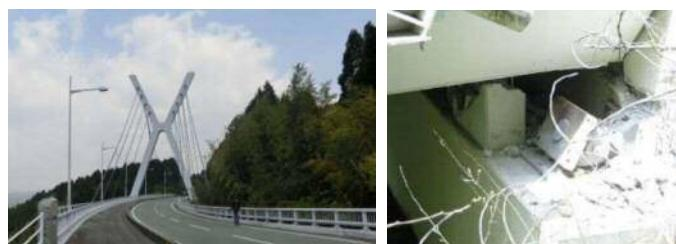
写真-2 支承部の損傷に伴う桁端部の浮き上がり
