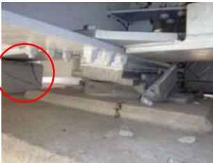
写真-6 支承の破損の状況
