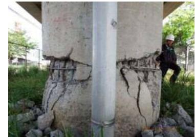
写真-7 段落し部の損傷
