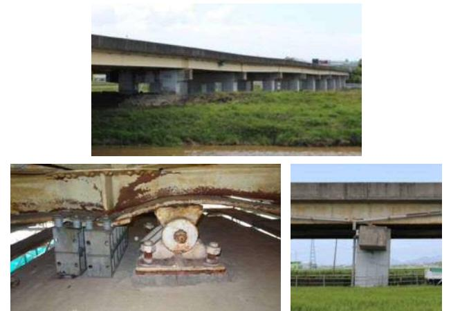
写真-1 支承部の損傷及び橋脚の傾斜
