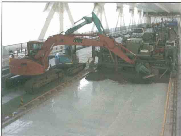
(写真) SFRC打設状況
