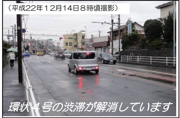
上下線トンネルが開通した後の状況
