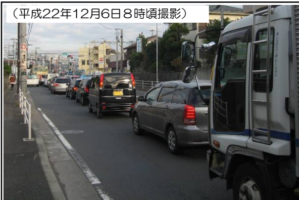
下り線トンネルが開通する直前の状況
