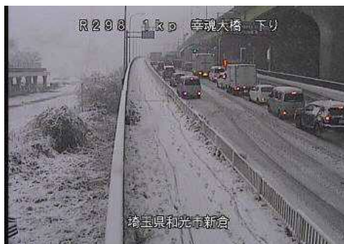
平成30年1月 国道298号 幸魂大橋道路状況
