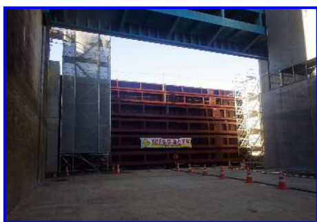
仮締切りゲートを設置して水を抜いた中の様子
