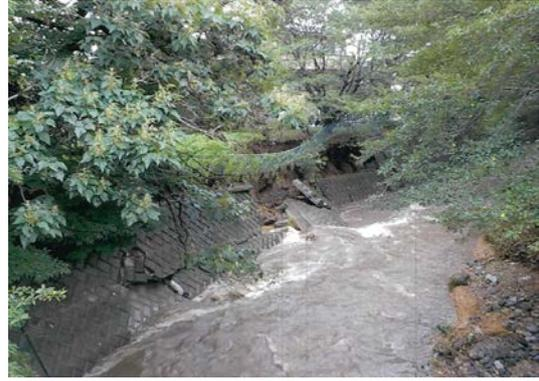
東川（稲荷橋付近左岸での護岸崩壊）
