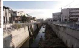
昭和23年～55年にかけて時間あたり30mmの雨に対処できる規模への全域の河道改修工事が実施され、その後は時間あたり50mmの雨に対処できる整備が進められています。写真は時間50mm規模の整備が完了した地点です。
