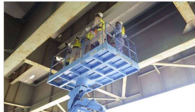
国道246号 新相模大橋（海老名市内）での現場実習
