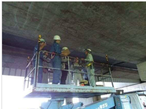
H26.10.19（神奈川県橋梁点検講習会）
