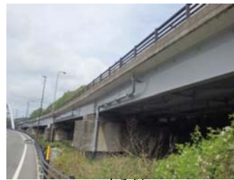
写真-4 阿蘇口大橋 (国道57号)
