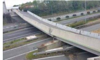
写真-1 県道小川嘉島線 府領第一橋
