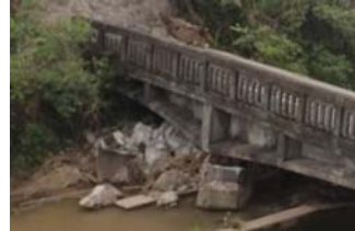
写真-2 平田・小柳線 田中橋
