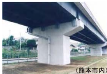
写真-3 国道3号 跨線部 (熊本市内)
