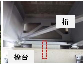
写真-5 アンカーバーのイメージ
