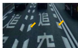
対策②:減速路面標示
