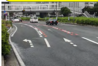
①減速路面標示 (ドットライン)
