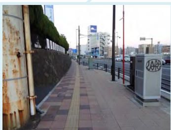
⑦上り流入部 歩道
