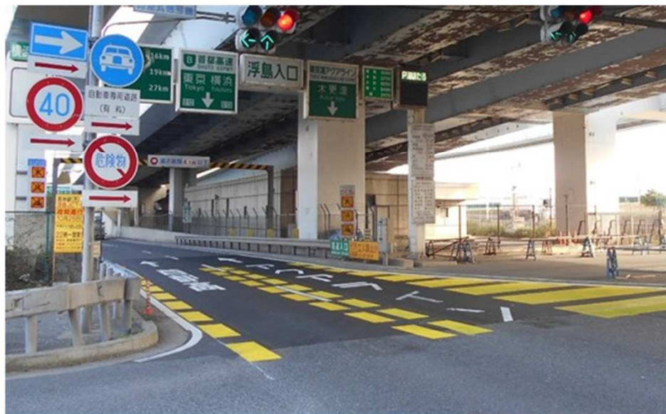
B 湾岸線 浮島入口
