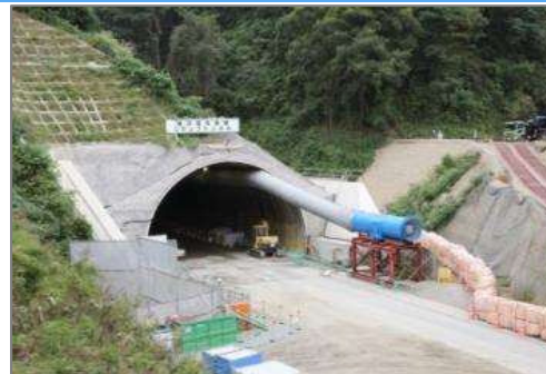
横浜環状南線 釜利谷JCTトンネル工事
