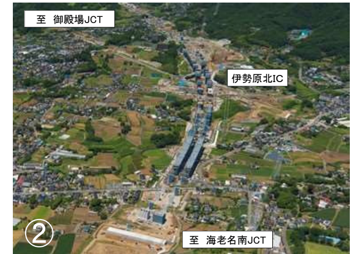
伊勢原市域 向畑高架橋付近の整備状況 (2018年7月撮影)
