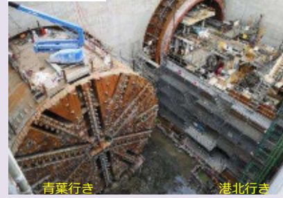
⑧到達立坑内部
