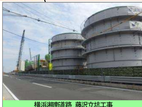
横浜湘南道路 藤沢立坑工事
