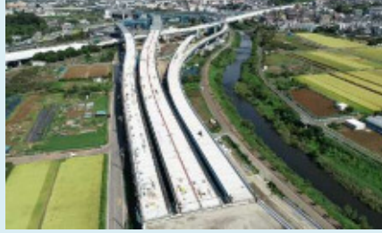
②全景(架設状況)
