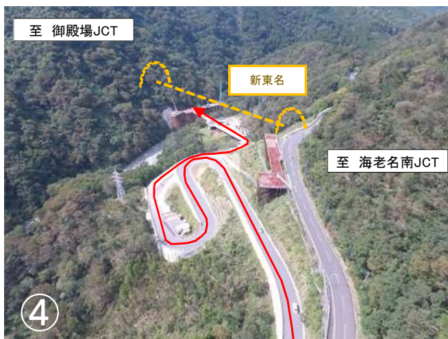
松田町域 中津川工事用進入路 (2018年10月撮影)
