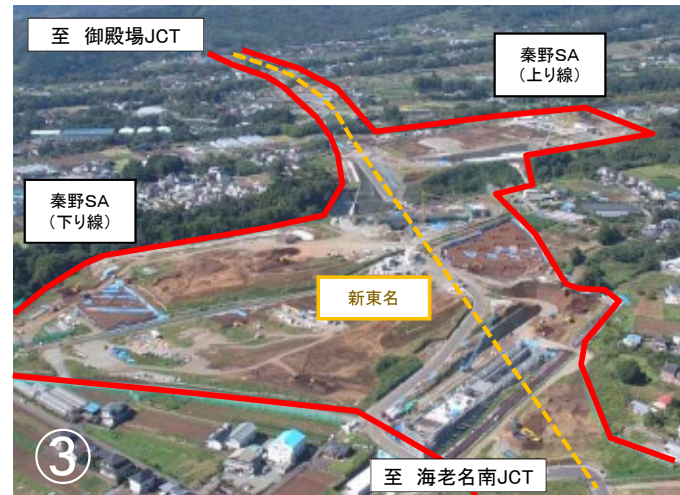
秦野市域 秦野SA (仮称) の整備状況 (2018年9月撮影)
