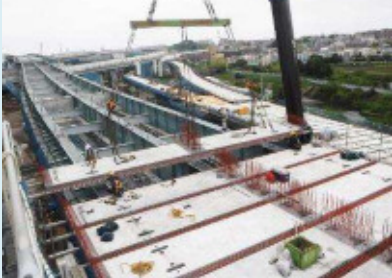
③床版架設状況(現時点ではすべて完了)
