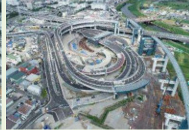
⑪横浜港北JCT付近の架設状況
