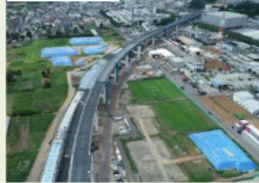
⑩全景(架設状況)
