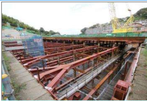
横浜環状南線 公田地区堀割試験工事
