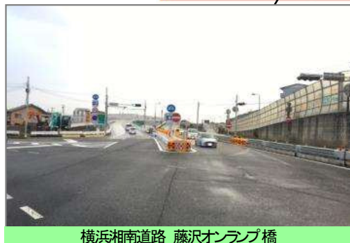
横浜湘南道路 藤沢オンランプ橋
