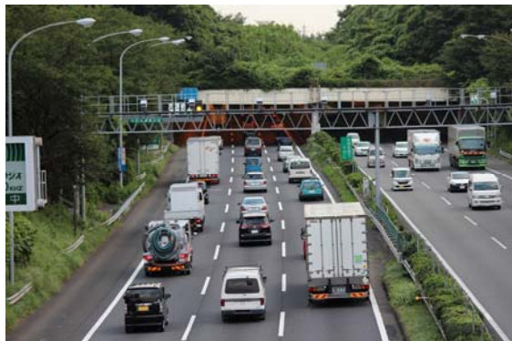
【①大和トンネル手前(上り線)】
