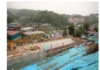
厚木環状3号線工事の様子(平成17年7月6日現在)
