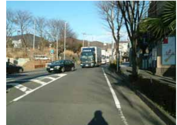
国道246号 名古屋交差点付近
