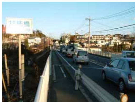
国道246号 沼代交差点付近
