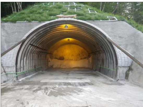
かもがりつむぎ ㉓ 鴨狩津向トンネル
