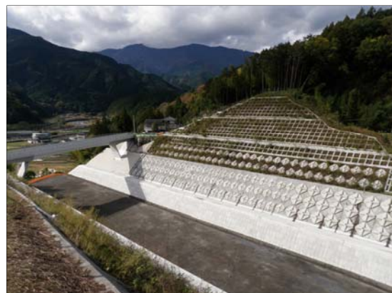
⑥ 柳島地区 やなぎしま 柳島地区土工部 (切土+7カー) 2013年3月完成
