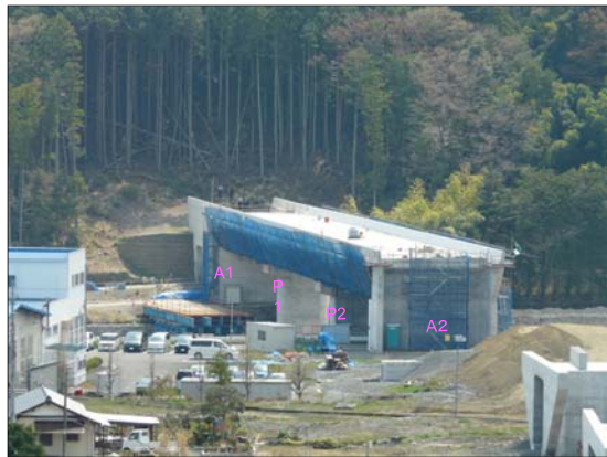
④ 戸栗川橋 とくり 全下部工が完成 上部工事を工事中 橋長：119m A1 P1 P2 A2
