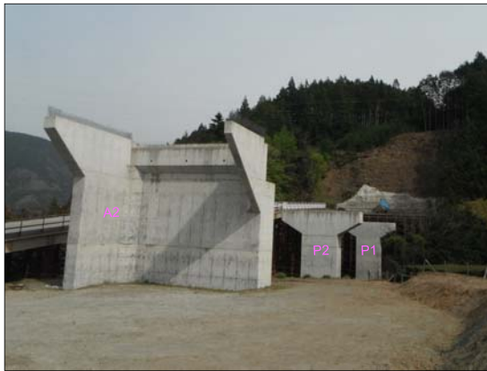
③ 栢根川橋 かぞね 2014年3月末全 下部工が完成 橋長：98m A1 P1 P2 A2
