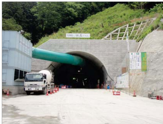
だいごやま 13 醍醐山トンネル ころうち トンネル坑口部 2011.5月末現在 掘削長 640m
