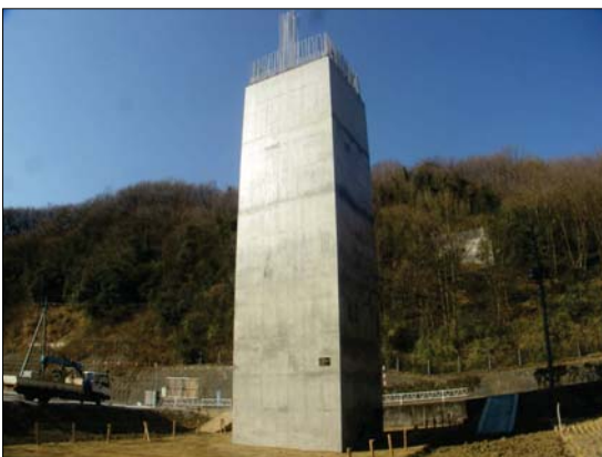
いっしき 17 一色川橋 P1橋脚 奥は、A2橋台
