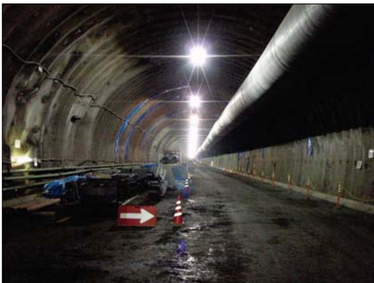
だいごやま 15 醍醐山トンネル トンネル坑内 (右上は排気ダクト)
