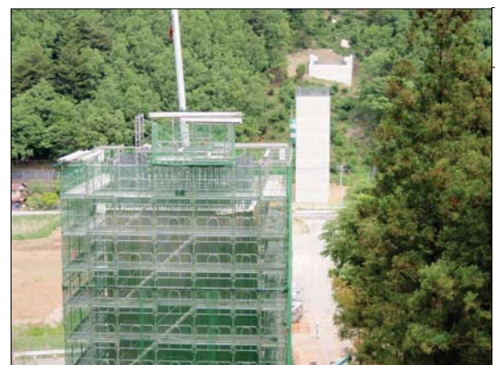
たんばら 18 田原川橋 手前がP1橋脚の 工食用足場、奥は、 P3橋脚・A2橋台 現在、A1橋台・P1 橋脚を工事中 P2橋脚は工事準備 中
