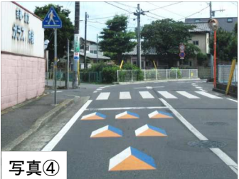
立体減速表示シート設置箇所 (平成30年3月設置)
