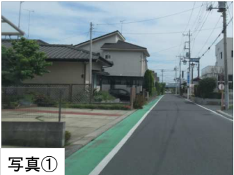
区画線及び路肩カラー設置箇所 (平成30年3月設置)
