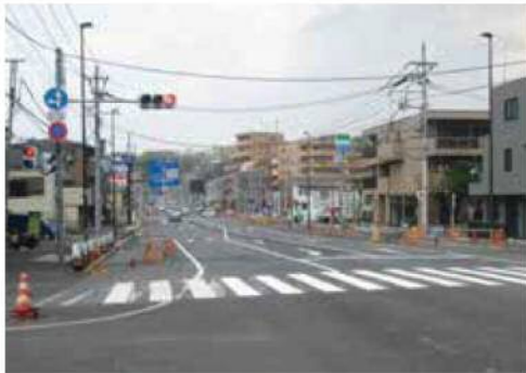
大中通り入口交差点付近の状況
