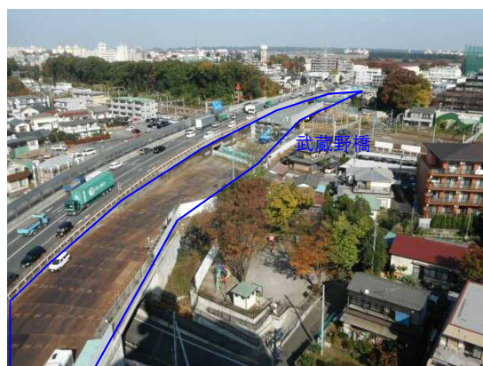
②武蔵野橋の施工状況
