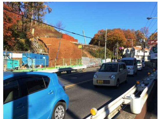
②稲荷坂交差点～中野山王2丁目地先 (H29年度開通区間)
