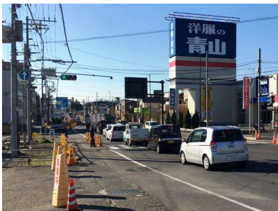
①中野上町交差点～稲荷坂交差点 (H29年3月開通区間)
