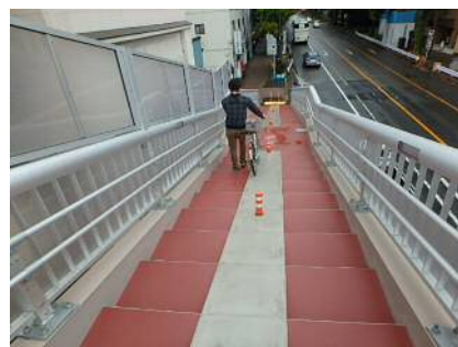
西側歩道橋通行状況
