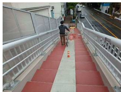
西側歩道橋通行状況
