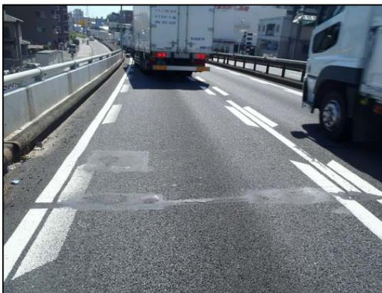
\* 写真は国道16号橋本陸橋でのジョイント損傷状況
