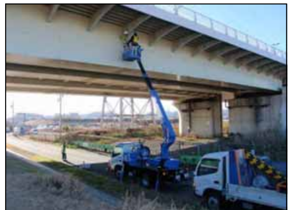
*写真は橋梁点検状況
