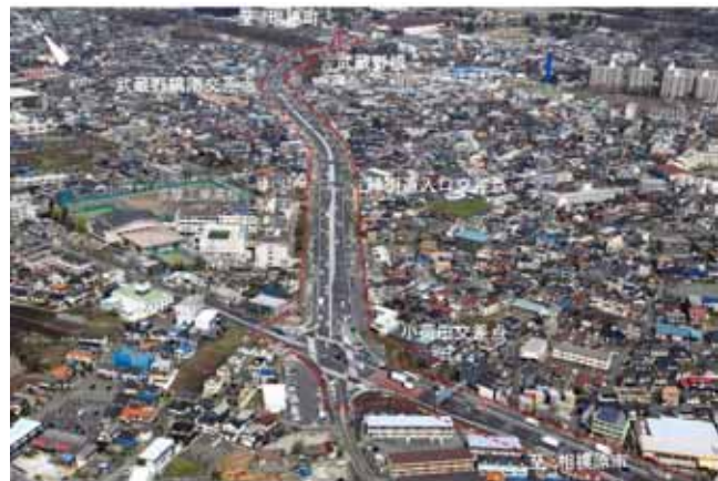
昭島市拝島町から瑞穂町方面を望む (平成28年3月撮影)
