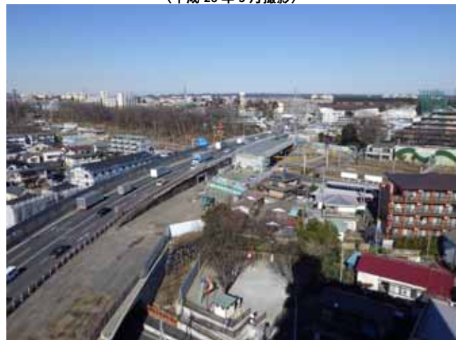
武蔵野橋付近の状況 (平成29年2月撮影)
