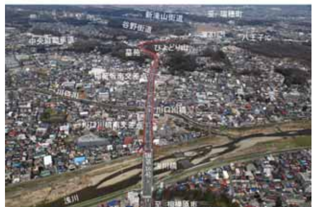
浅川橋から川口川橋方向を望む (平成28年3月撮影)
