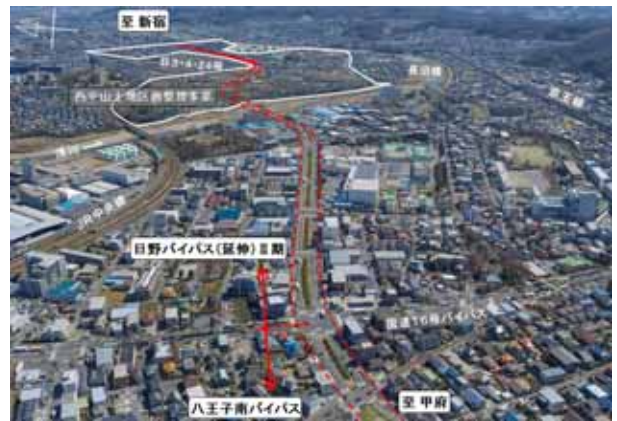
北野橋南交差点から新宿方向を望む (平成28年3月撮影)
