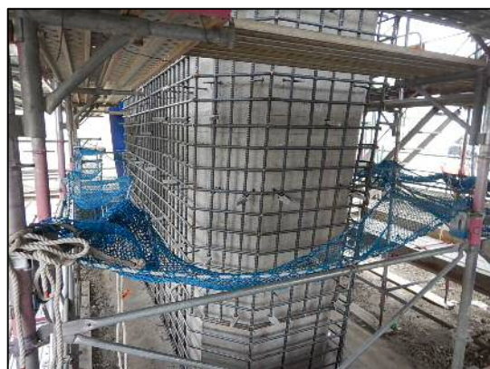
* 写真は国道16号BP大和田高架橋での 橋脚補強実施状況
