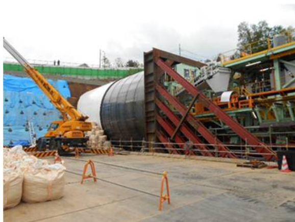
館第一トンネル坑口（高尾側）付近 （平成30年4月撮影）
