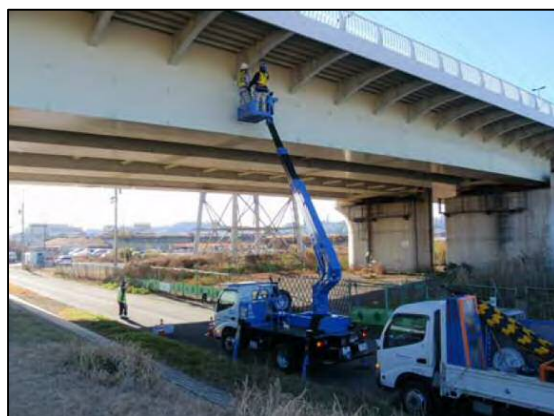
* 写真は橋梁点検状況
