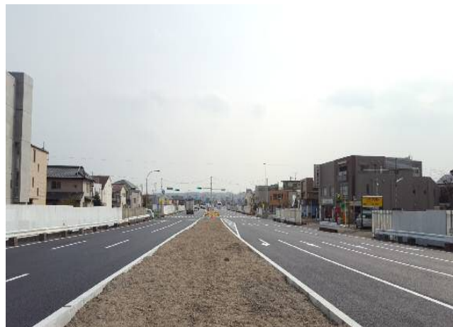
松原町5丁目交差点付近 (平成30年3月撮影)
