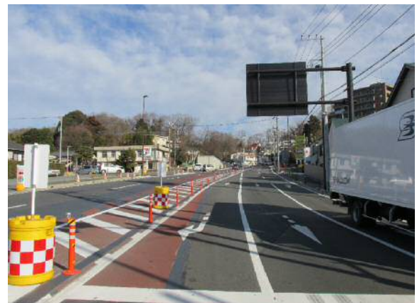
4車線化した稲荷坂交差点付近の状況 (平成30年1月撮影)
