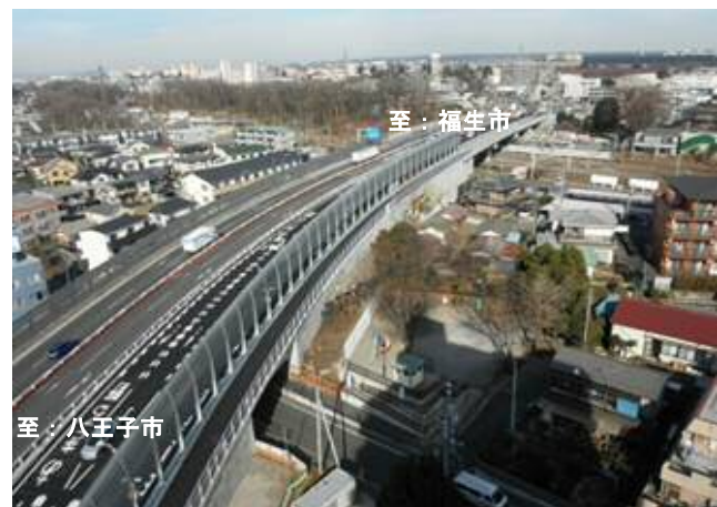
武蔵野橋付近の状況 (平成30年3月撮影)
