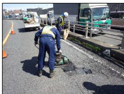
路面補修状況
