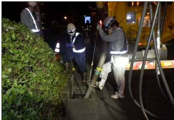
③豪雨に備えて道路排水管清掃の実施
