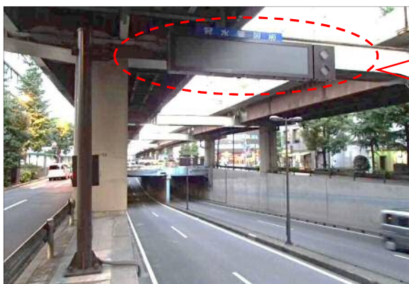
①アンダー手前に冠水情報を提供する電光標示板設置
