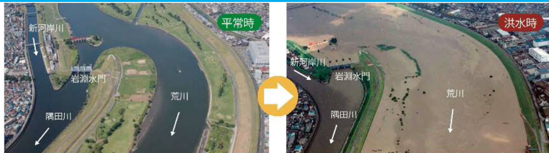
岩淵水門周辺における平常時と洪水時(平成11年8月)の比較
