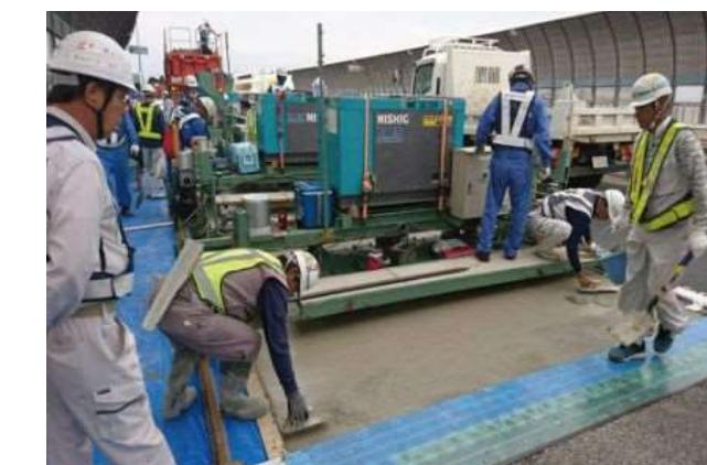
通常ならば、表面の舗装を撤去した後、鋼床版の上にすぐアスファルト舗装を施工しますが、リニューアル事業では、橋梁の長寿命化を図るため、剛性の高いコンクリート(SFRC:鋼纖維補強コンクリート)をまず施工します。
