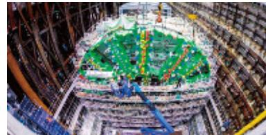
断面直径が16mにもなる国内最大級のシールドマシンの組み立て(大泉JCT) 平成30年7月4日撮影
