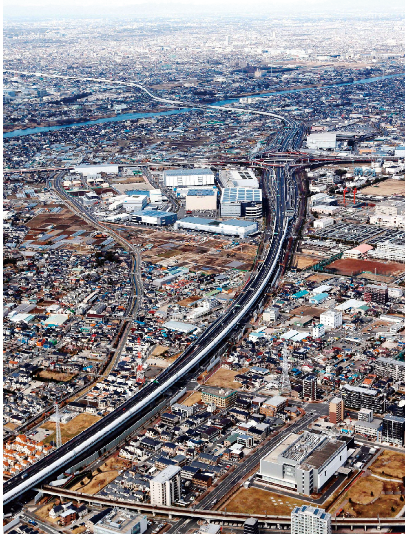
周囲に多数の大型物流施設が立地する三郷JCT ([C3]外環道—[E6]常磐道・首都高速6号三郷線) 平成30年3月2日撮影
