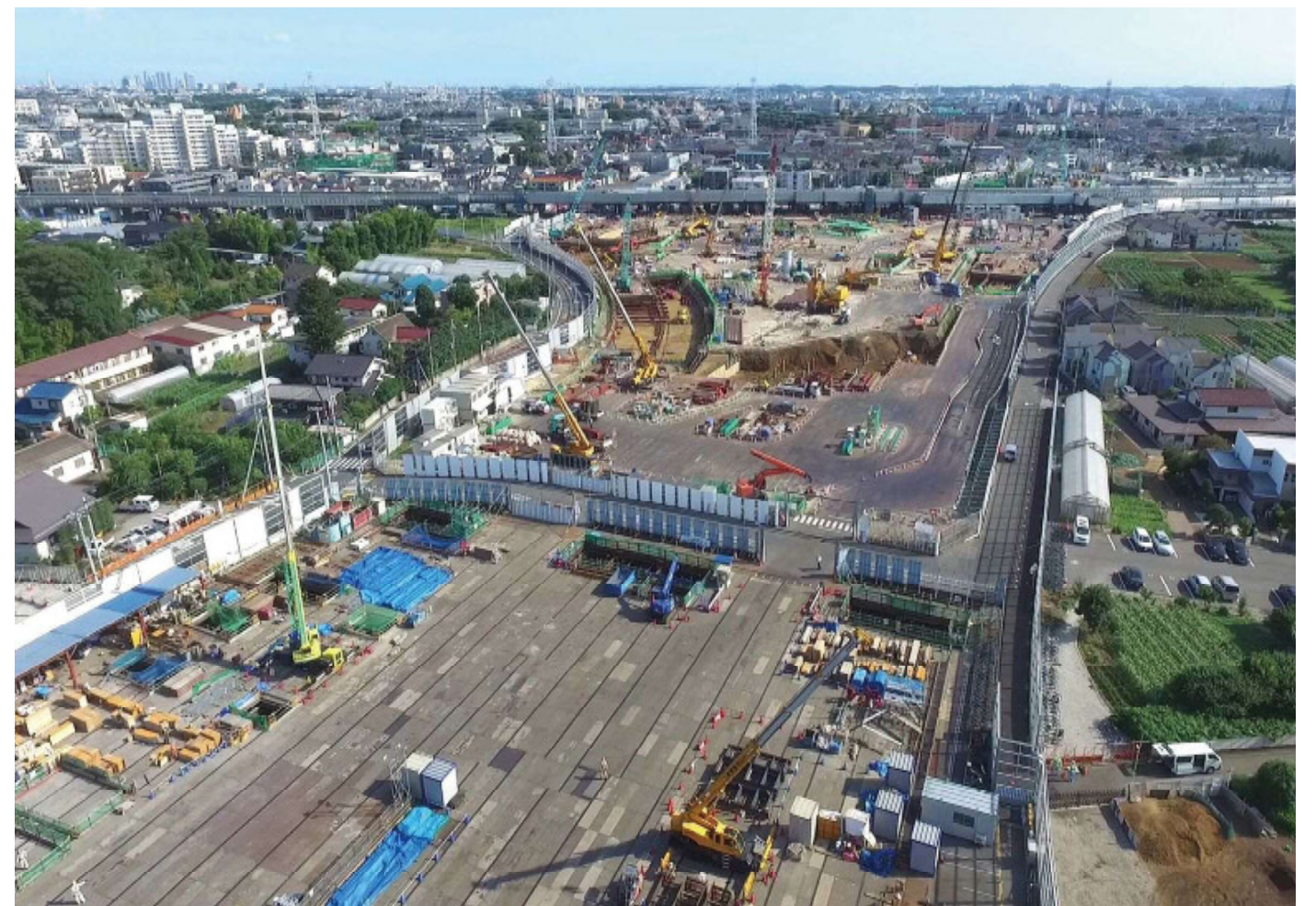
地上部分で整備が進む中央JCT(仮称) ([C3]外環道—[E20]中央道) 平成30年7月20日撮影
