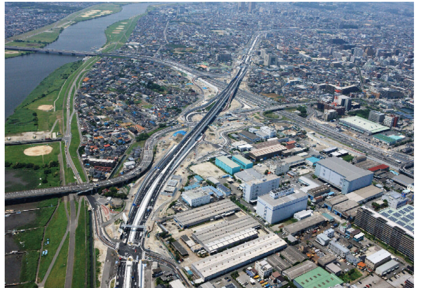
高速道路同士を地下で接続する京葉JCT ([C3]外環道—[E14]京葉道路) 平成30年6月26日撮影
