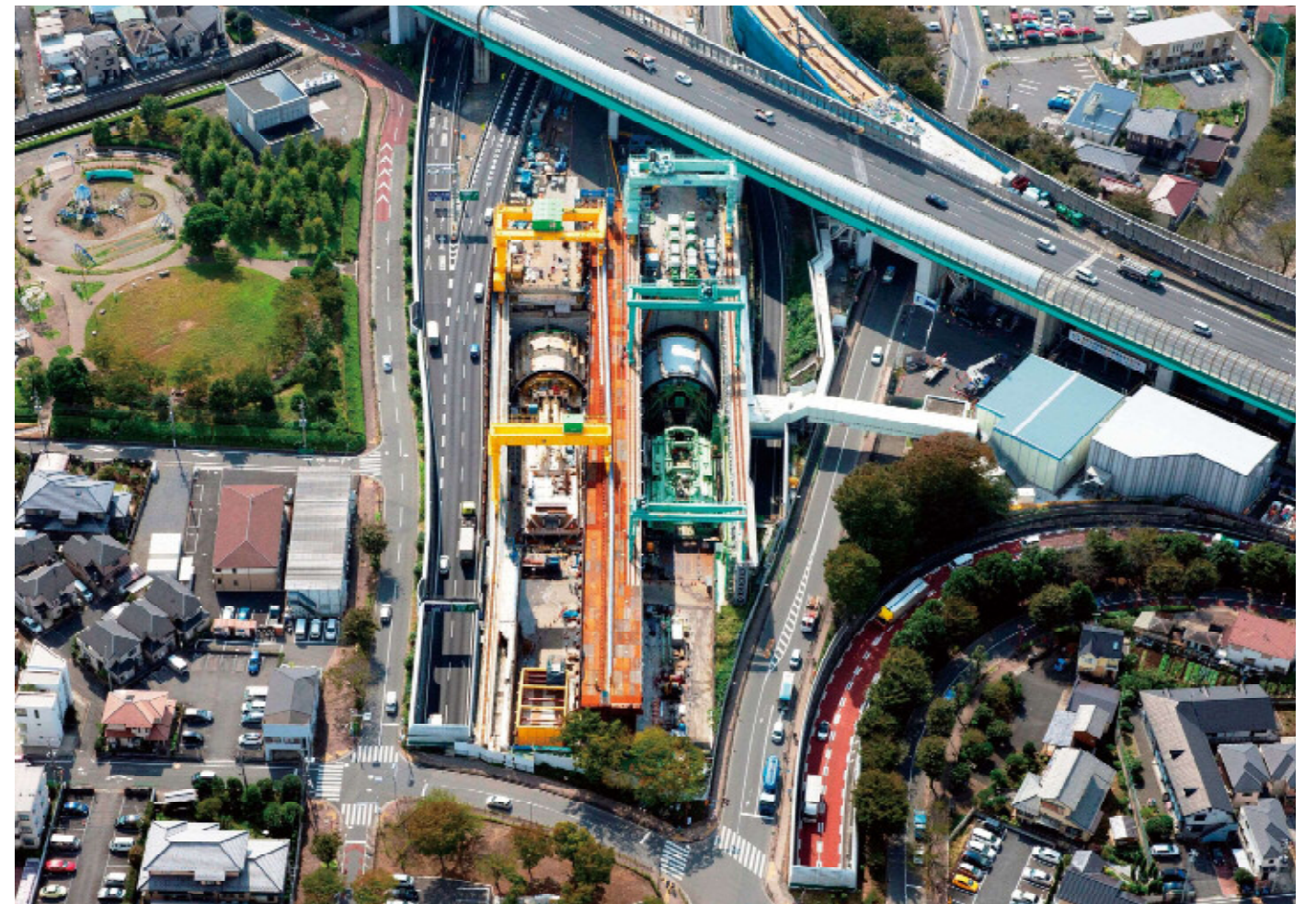
中央道・東名高速方面に向かってシールドマシンが発進する大泉JCT([C3]外環道—[E17]関越道) 平成30年10月25日撮影
