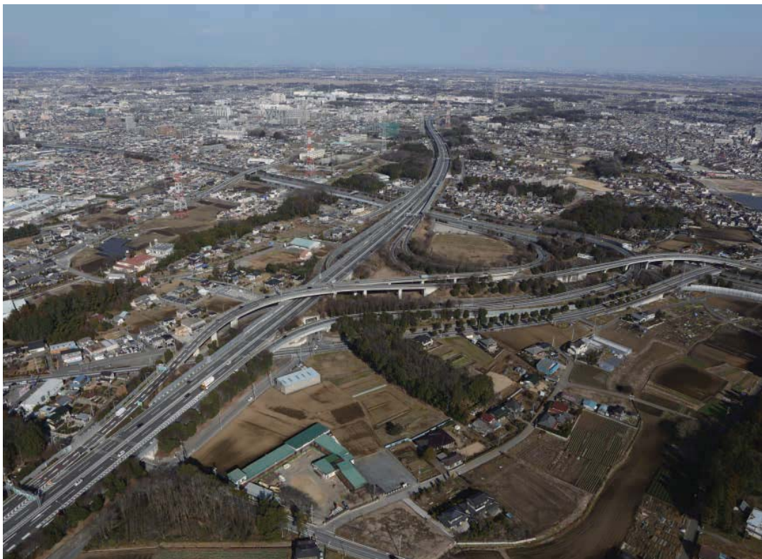
鶴ヶ島JCT(圏央道—関越道) 平成29年1月3日撮影
