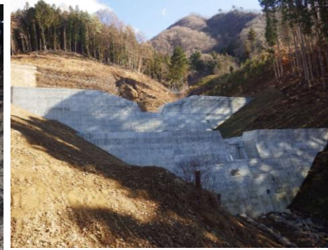
完成状況 (H30.12)
