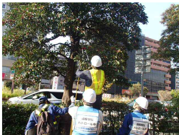
鶴見区役所前 (街路樹の高さ不足の枝を伐採)
