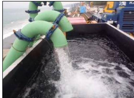
鋼矢板打設に必要な水をタンクに貯水
