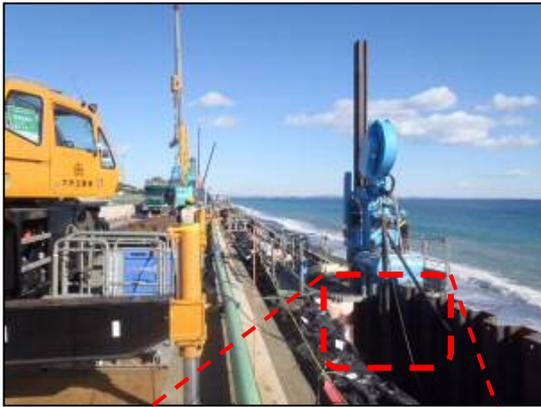
鋼矢板打設 ウォータージェット施工状況
