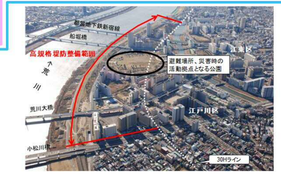
高規格堤防とあわせて広大な公園や中高層住宅等が整備
