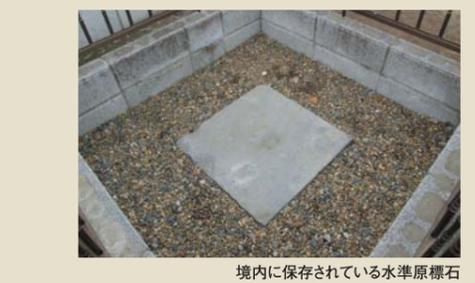
飯沼観音の境内の一角に、柵に囲われて保存されている石があります。これは、水準原標石と言い、水準測量(高さを測る測量)を行う時の原点となる点のことです。利根川、江戸川の水準測量を開始する時にオランダ人技師のリンダは、千葉県銚子市にある飯沼観音内に水準原標石を設置し、これを基準に飯沼水位尺(量水標)の基本水平面を日本水位尺(J.P.)と名付けました。ここから、利根川、江戸川の基本水平面(Y.P. 0.0m)の高さや荒川の基本水平面(A.P. 0.0m)の高さが決まり、現在の河川における基準高となっています。
