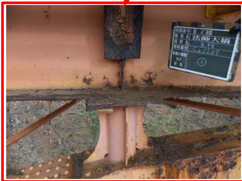
橋桁等の鋼部材の腐食
