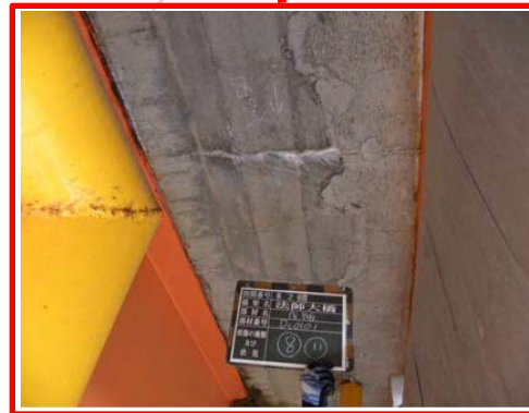
コンクリート床版のひびわれ
