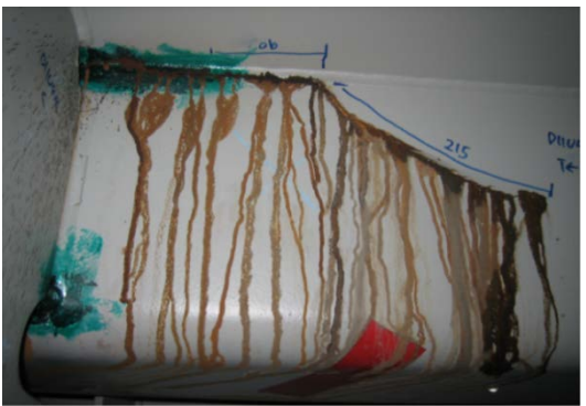
橋桁の内部へ進展した亀裂 ※亀裂からの漏水跡は、路面より浸入
