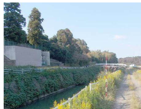
稲荷川護岸状況写真
