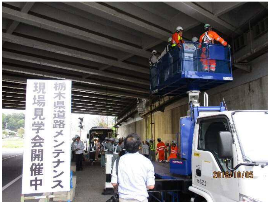
橋梁点検研修(犬伏橋)
